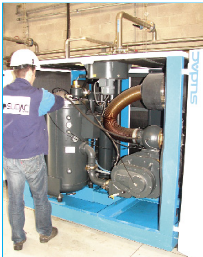
Intervention sur centrale SUDAC
